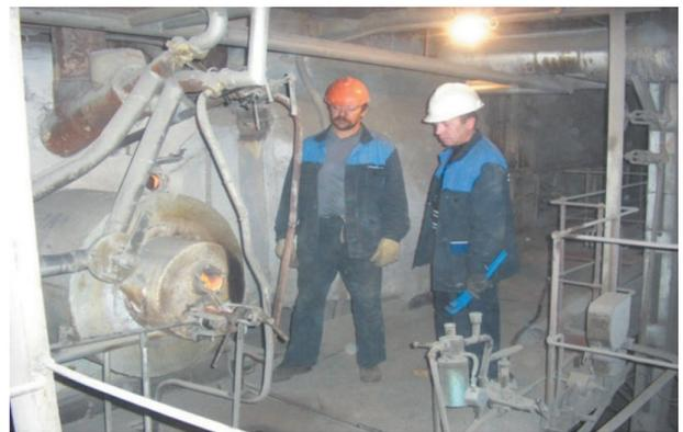
Рис. 26. Система безмазутной растопки паровых котлов BK3-420-140
