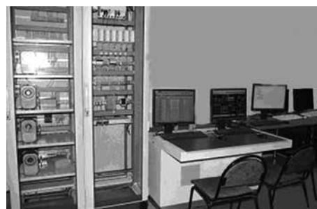
Рис. 3. ПТК Freelance 800F (ABB, Германия)
